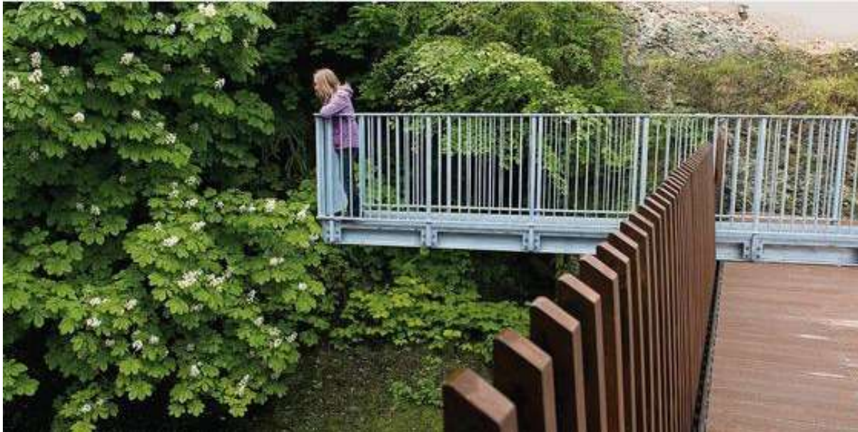
Aussichtssteg zum Kolk der Steinach, St. Georgenstraße, 9000 St. Gallen
